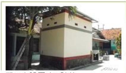
機器を設置する建物
